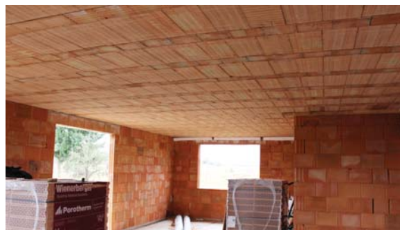
Strop po zabetonování
